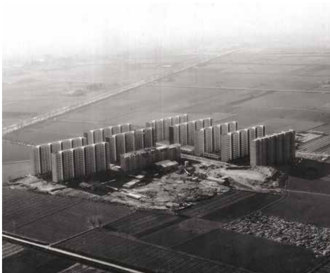
Fig. 4. Fotografía de un polígono de vivienda social, de los centenares que se construyeron en todo el estado. Barrio de Bellvitge, Hospitalet (autor y fecha desconocida).
